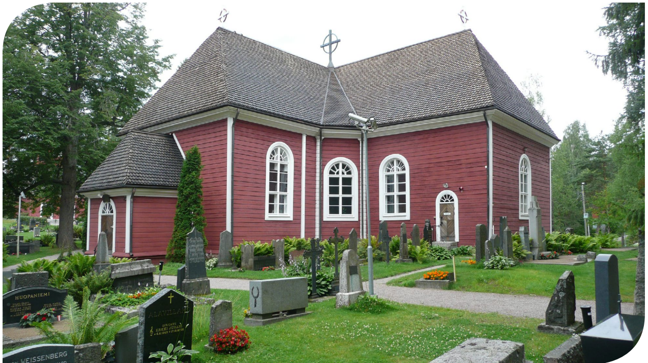
Teiskon kirkko. Kuva Rakennusvalvonnan kuva-arkisto.
